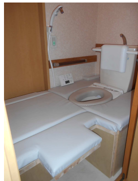
頸髄損傷者の高床式トイレ
